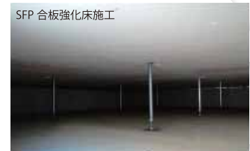
SFP 合板強化床施工
