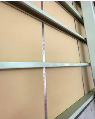
室内側施工状況
