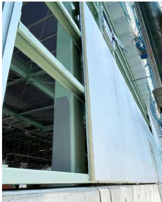
室外側施工状況
