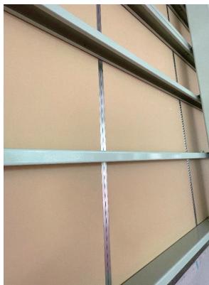
室内側施工状況
