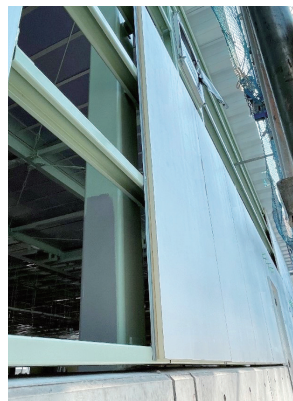
室外側施工状況
