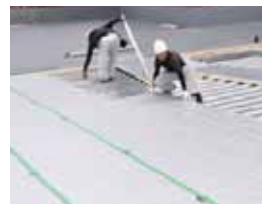
敷設している様子
