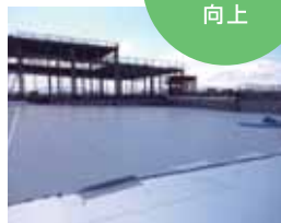
施工状況(手前が「サーマックスRII」)
