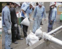
土嚢の積み方確認
