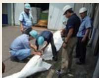
オイルフェンスの設置
