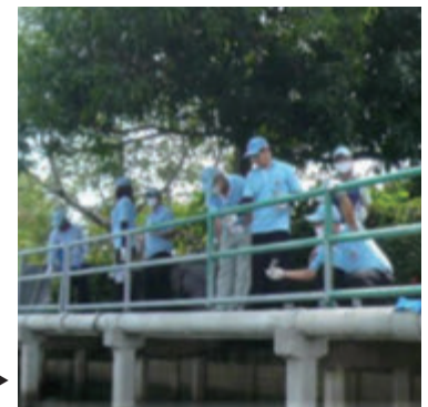
近隣住民も使用する工場の裏側のフェンスのペンキ塗り
