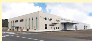
垂井工場の壁・屋根を断熱
