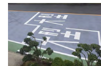
遮熱性舗装 (赤外線を反射して路面温度を下げる)
