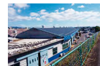
屋根カバー工法
