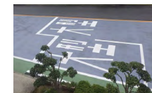
遮熱性舗装 (赤外線を反射して路面温度を下げる)
