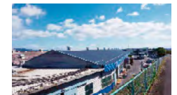
屋根カバー工法
