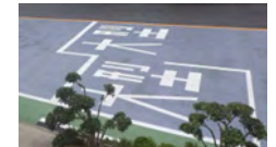
遮熱性舗装 (赤外線を反射して路面温度を下げる)
