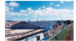
屋根力カバー工法
