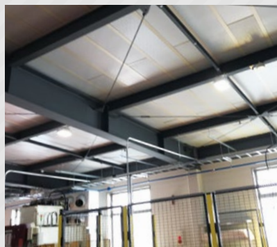
「サーマックス」による作業場の断熱
