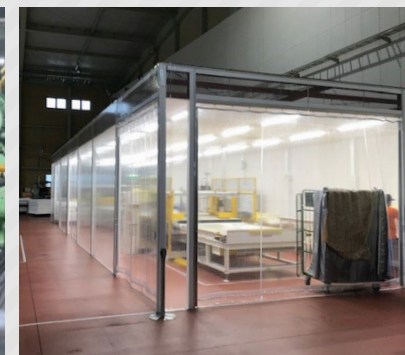
作業空間の間仕切り
