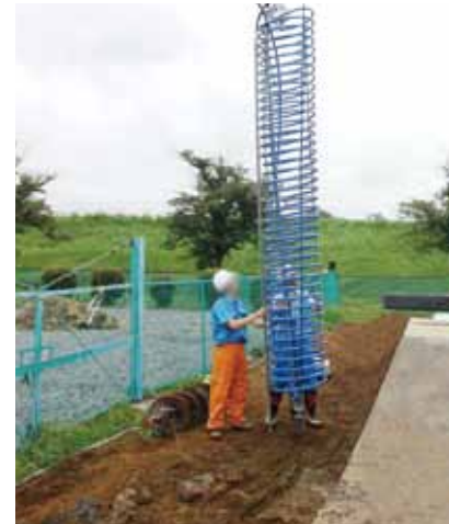
スパイラル型熱交換器の施工
