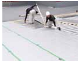
敷設している様子
