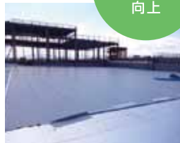
施工状況(手前が「サーマックスRII」)
