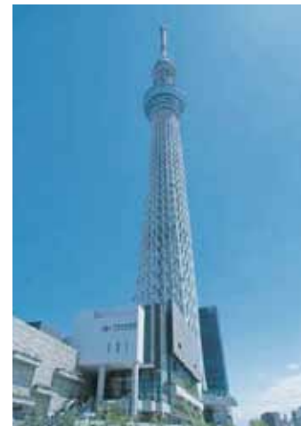
東京スカイツリー地区 環境省「地中熱利用システム パンフレット」より
