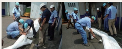
オイルフェンスの設置
