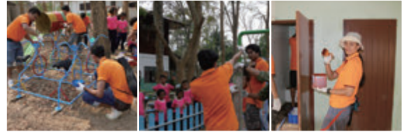
▲小学校にて修繕活動
