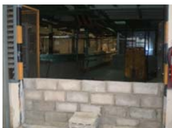
ブロック塀で洪水対策
