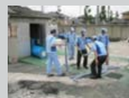
流出防止キットの設置作業
