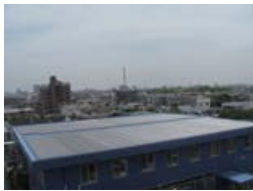
事務所棟屋根に設置したルーフシェード(安城事業所) ▶
