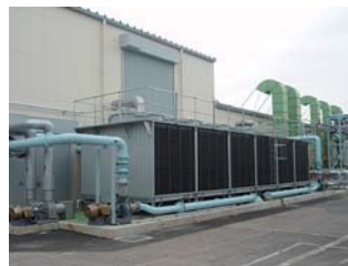
A-1 塗装ライン工場外観
