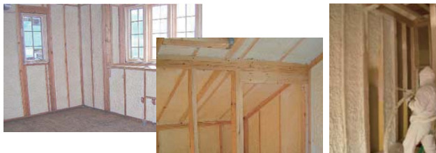
フォームライト SL 施工様子
