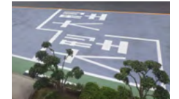
遮熱性舗装 (赤外線を反射して路面温度を下げる)
