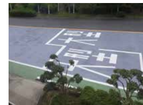
遮熱性舗装 (赤外線を反射して路面温度を下げる)
