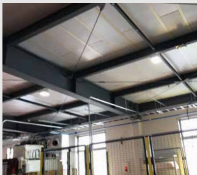
「サーマックス」による作業場の断熱
