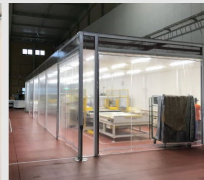
作業空間の間仕切り
