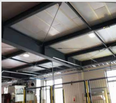
「サーマックス」による作業場の断熱
