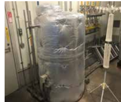
タンク保温ジャケット取り付け
