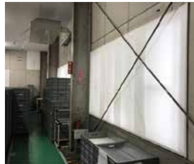
「セルシェード」の窓ガラスへの施工
