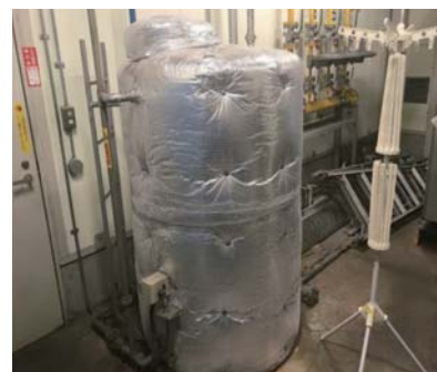
系列会社／タンク保温ジャケット取り付け
