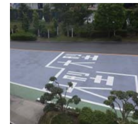
遮熱性舗装 (赤外線を反射して路面温度を下げる)
