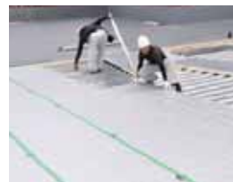
敷設している様子
