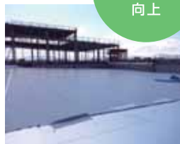
施工状況(手前が「サーマックスRII」)
